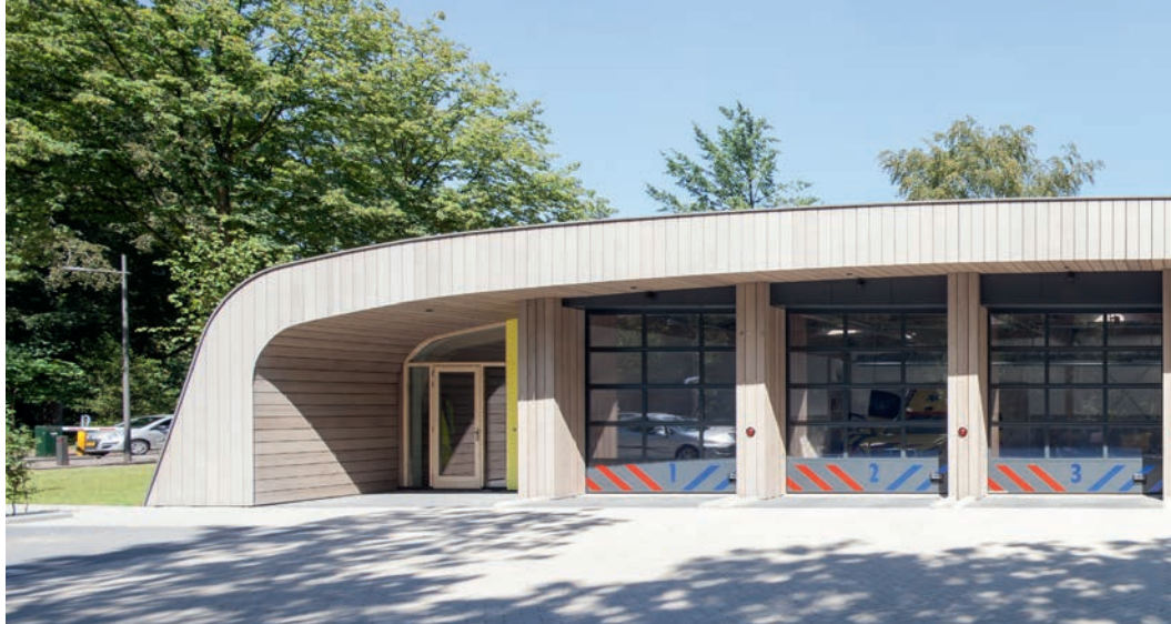
Stalling van buiten. Ieder geveldeel moest apart worden ingemeten, in de lijn van het dak gezaagd en ten slotte genageld.
